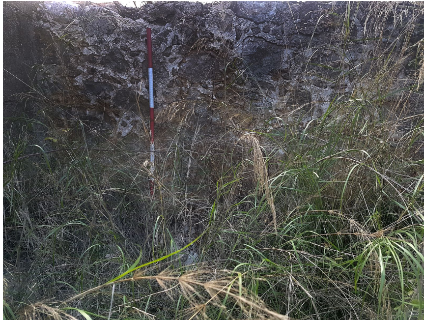
Fig. 19. Detall de la paret del Safareig Petit de la Mina Vella.
