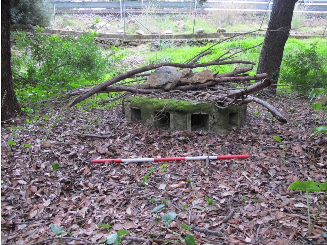
Fig. 5. Detall de l'exterior del Pou (2) de la Mina Vella.
