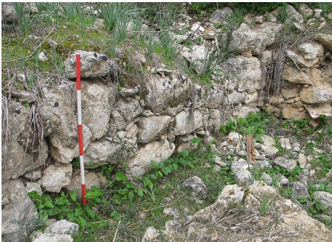
Fig. 6. Mur interior de la Naveta de Son Cladera (1).
