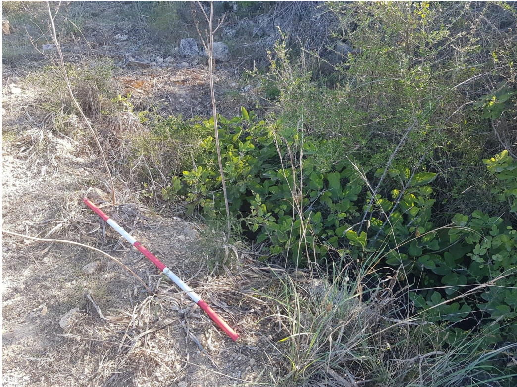
Fig. 17. Detall de l'esfondramnet entre el pou (1) i la canal.
