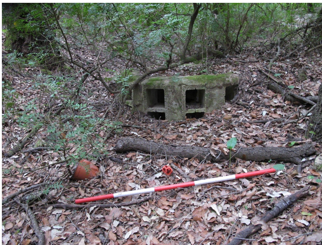
Fig. 3. Detall del exterior del Pou (1) de la Mina Vella.
