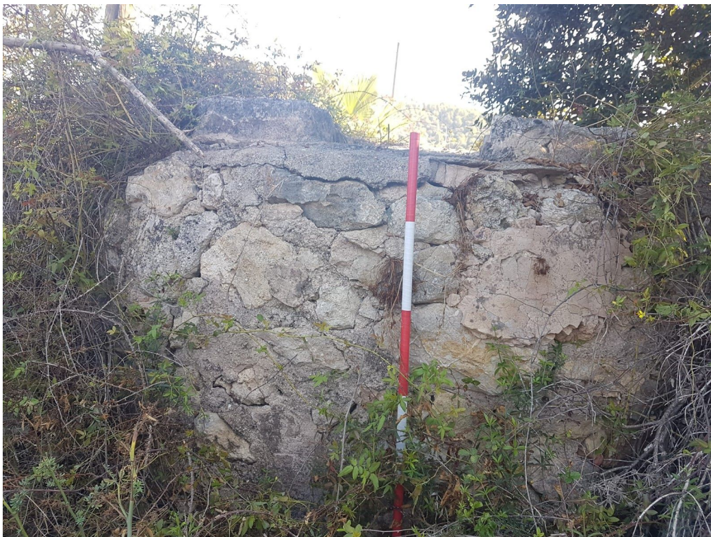
Fig. 8. Detall de l'exterior del pou (6) de la Mina Vella.
